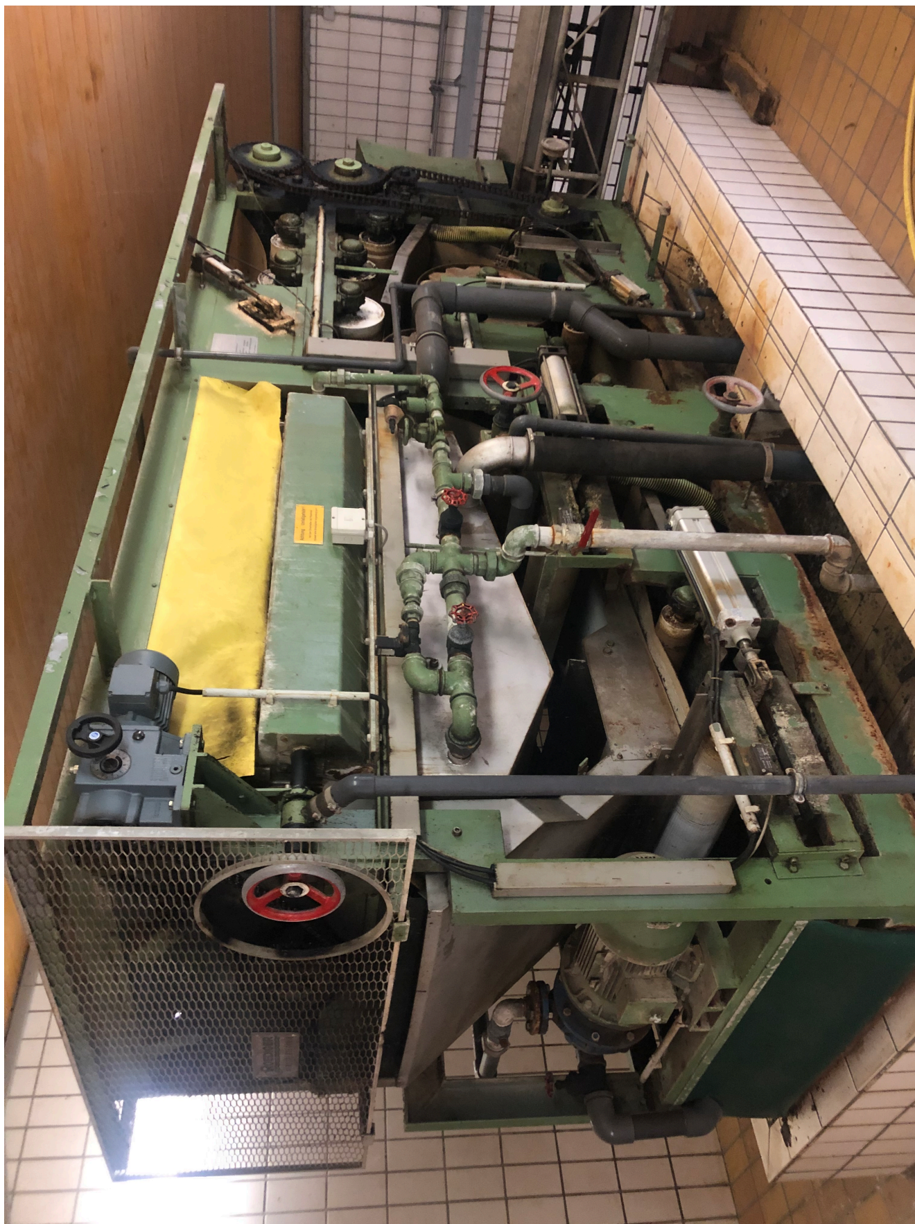
Alte Schlammpresse, welche im Rahmen der Dachsanierung ausgebaut und entsorgt wird
