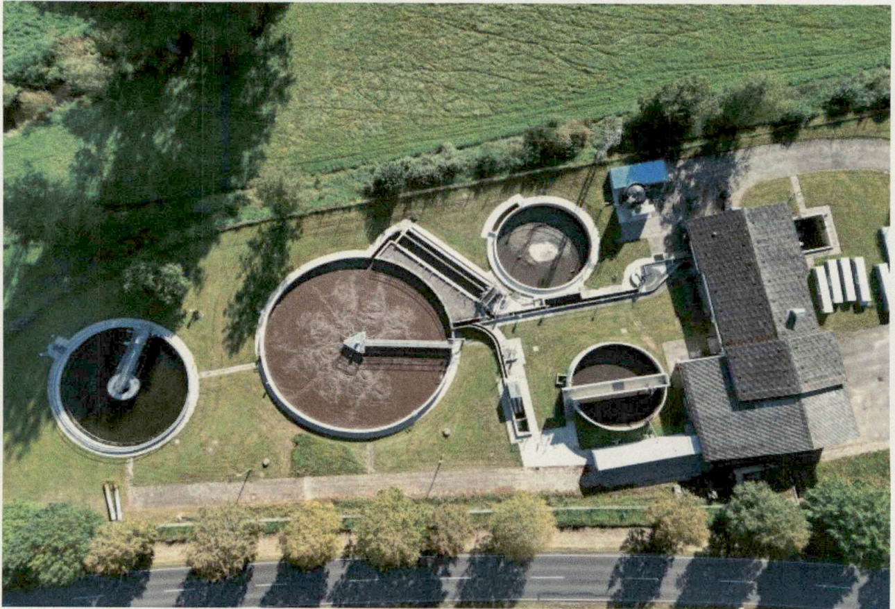
Sicht auf die Kläranlage - September 2023
