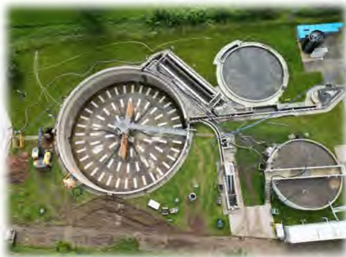
Verteilung und Anschluss der neuen energieeffizienteren Bodenbelüftungsplatten
