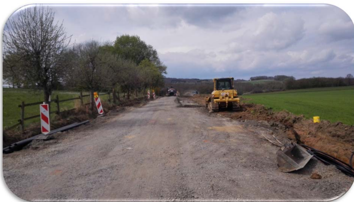
Verwendung Landes-KIP-Mittel --- Straßenbau „In der Hinterbach“ Hainzell
